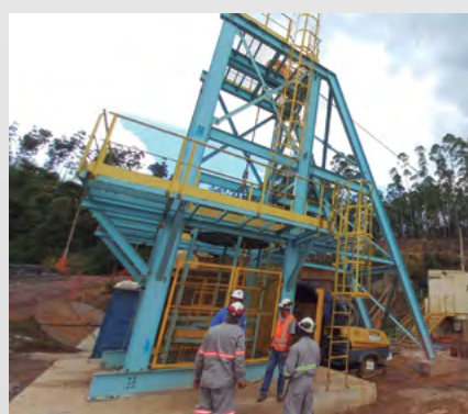
Torre e plataforma usadas na obra
