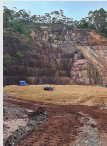
Obras da disposição de rejeito em cava em CCA/RG
