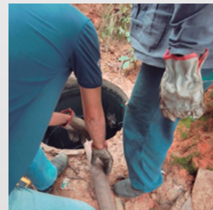
Limpeza de fossas em residências no distrito de Rancho Novo
