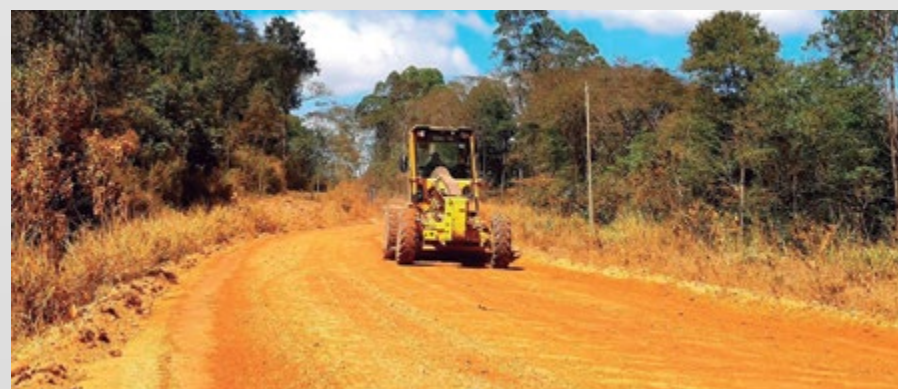
Melhorias na estrada
