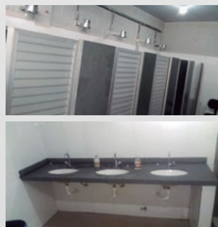
Melhorias nos vestiários de CCA/Pilar
