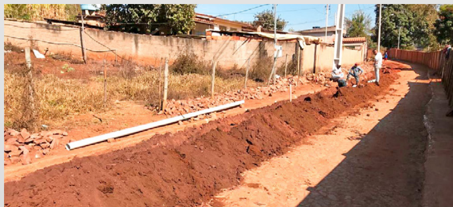
Obras em fase de conclusão
