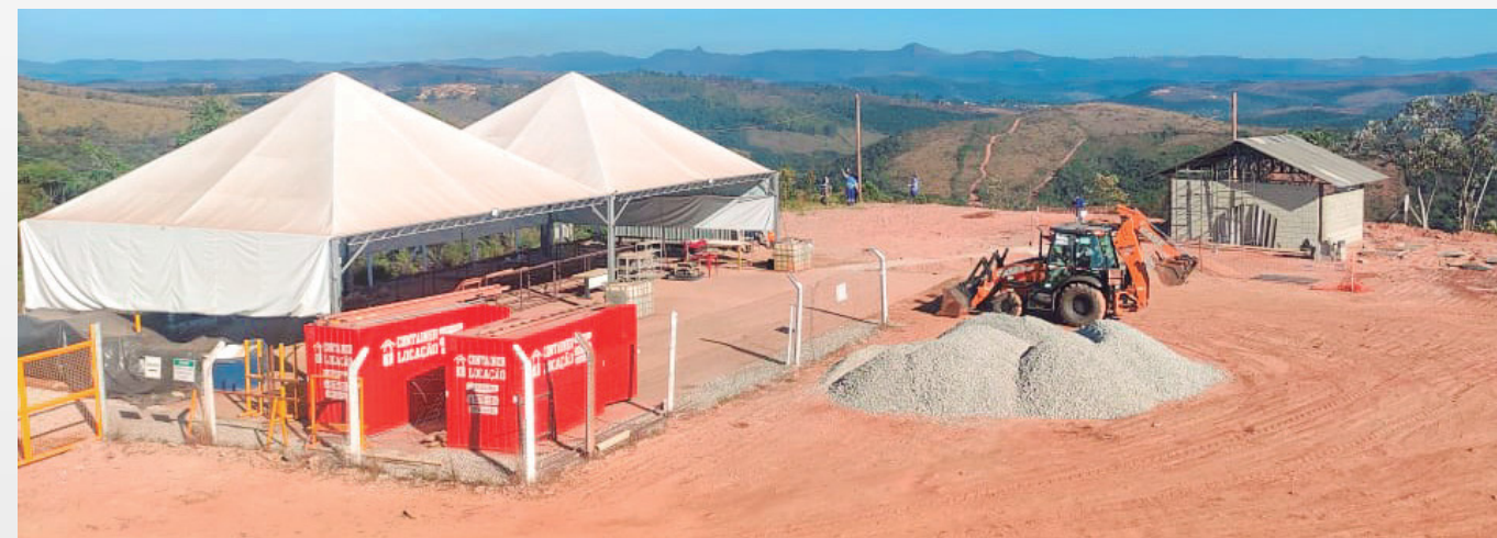
Vista geral das obras
