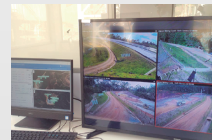
Sistema monitorando movimentação de placas instaladas nas barragens
