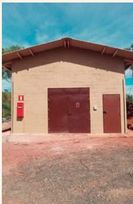
A nova cabine de medição da Cemig na unidade MTL
