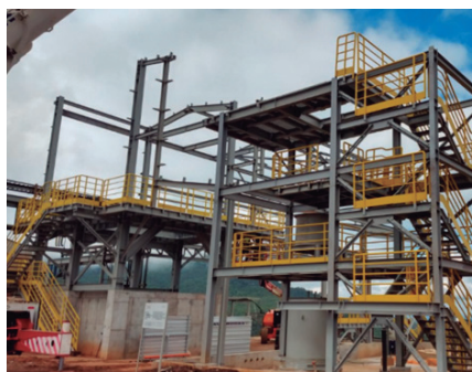
A nova estrutura em CCA/RG
