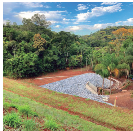
Maciço da barragem foi reforçado
